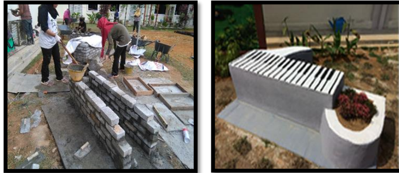
Rajah 9: Pembinaan Bangku Taman Dan Kemasan Akhir Dengan Mengecat Di Tapak Landskap
