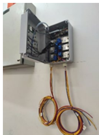
Proses memasang Device Controller di bilik DB
