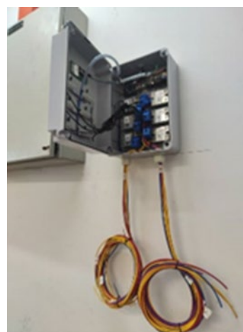
Proses memasang Device Controller di bilik DB
