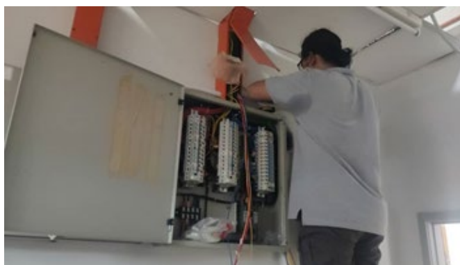
Proses menyambungkan Device Controller dengan DB
